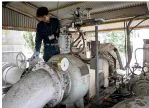
現場におけるポンプおよび周辺機器の点検
